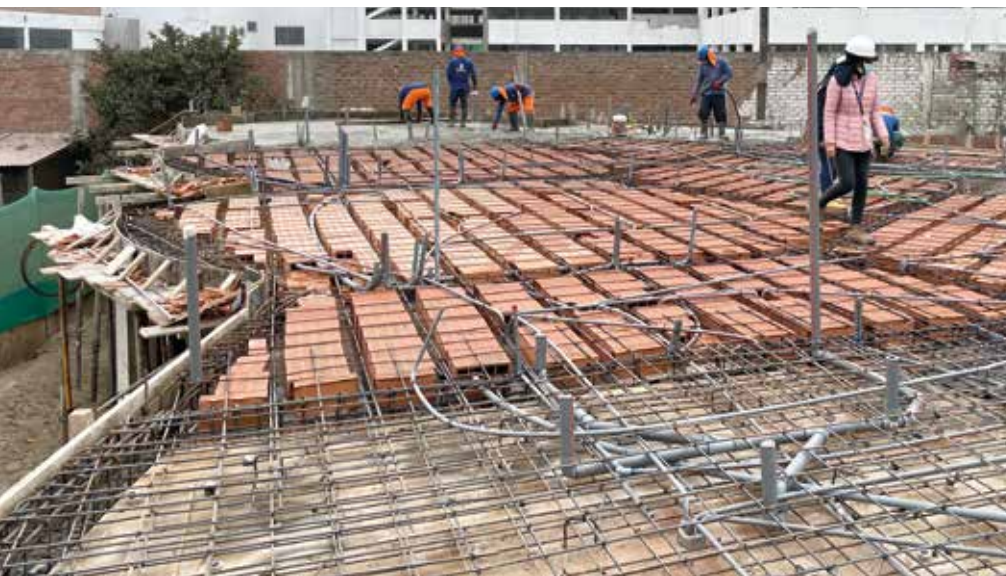
Het storten van de verdiepingvloer, met holle-baksteen elementen
