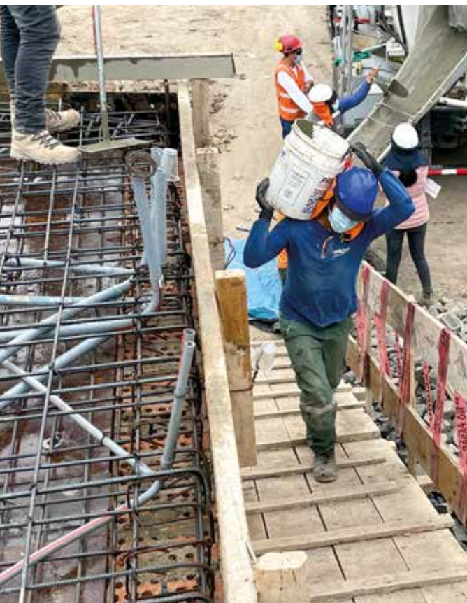
Het storten van de verdiepingvloer, met holle-baksteen elementen
